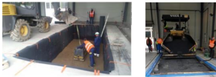
FIGURE 1. (à gauche): Remplissage de la fosse (à droite) : Mise en œuvre des enrobés.
