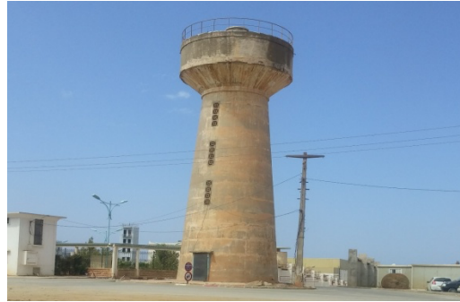
FIGURE 1. Vue de la structure du château d'eau étudiée
