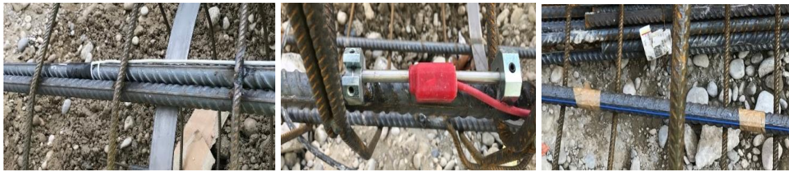
FIGURE 2. Photos prises sur chantier (à gauche, une jauge de déformation, au milieu, un extensomètre à corde vibrante et à droite, une fibre optique)
