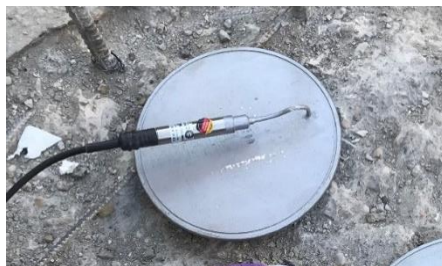
FIGURE 3. Capteur de pression totale installé sur une tête de pieu après recépage
