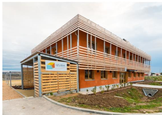
Bureaux d'IZUBA à Fabrègues, Architecte : Vincent Rigassi (photo Steven Morlier)
