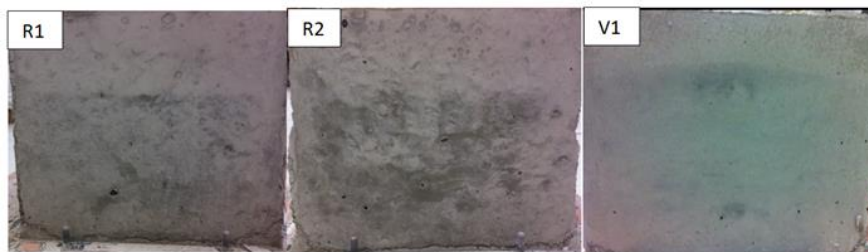
FIGURE 1. Parement en béton de R1, R2 et V1 à 1 jour
