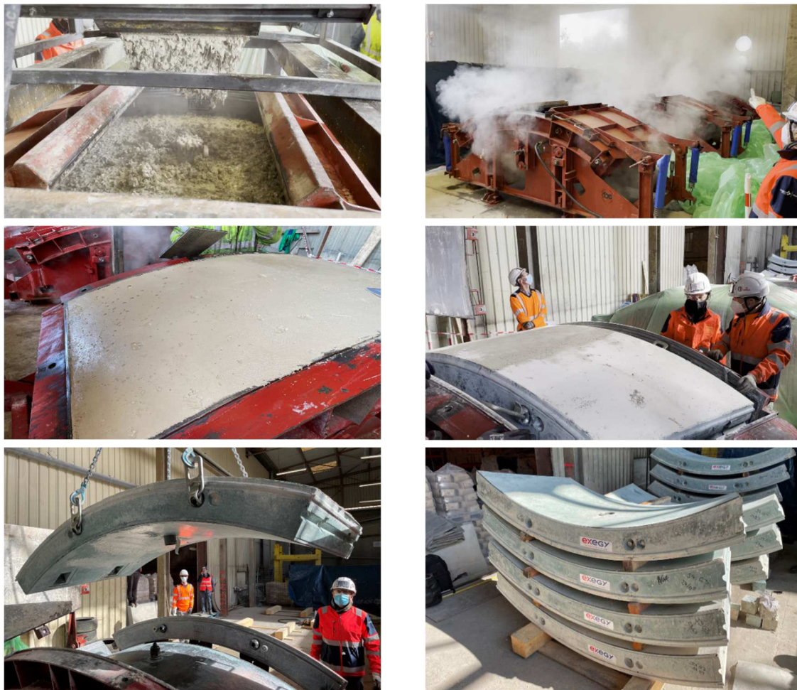
FIGURE 8. Illustrations d’une campagne de fabrication en usine de voussoirs destinés à recouvrir les parois de tunnels creusés dans le cadre de l’expansion du métro du Grand Paris.
