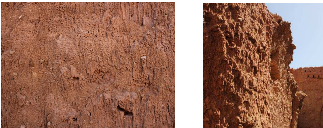
Figure 6. Mur construit en adobe salin
