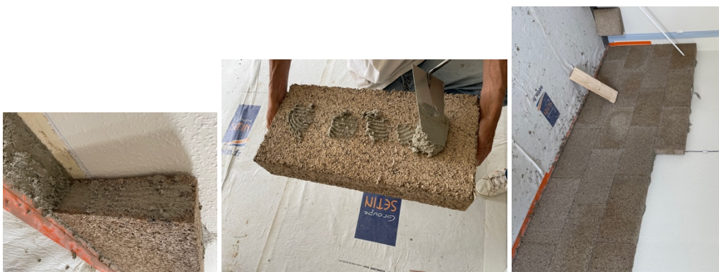
FIGURE 2. Montage du parement en béton de chanvre
