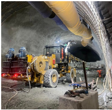
Figure 3 - Méthode conventionnelle (chantier TELT)
