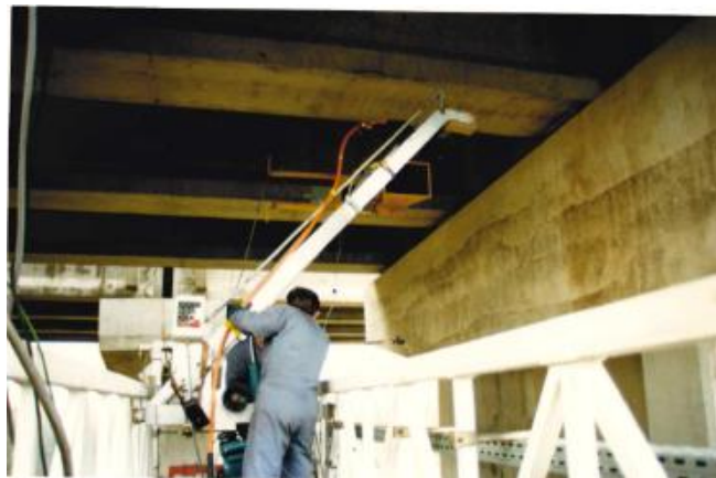
FIGURE 6. Installation des pantographes sur une poutre
