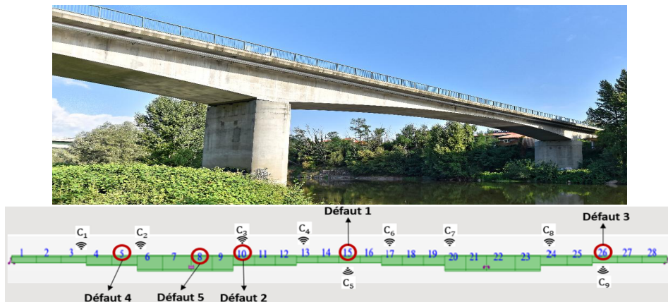
FIGURE 3. Pont de Longues : ouvrage, modèle numérique et localisation des capteurs et des défauts.
