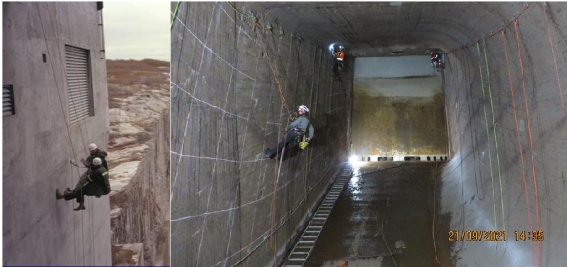
Figure 2 - Inspection par appui sur cordes extérieures et dans un passage hydraulique
