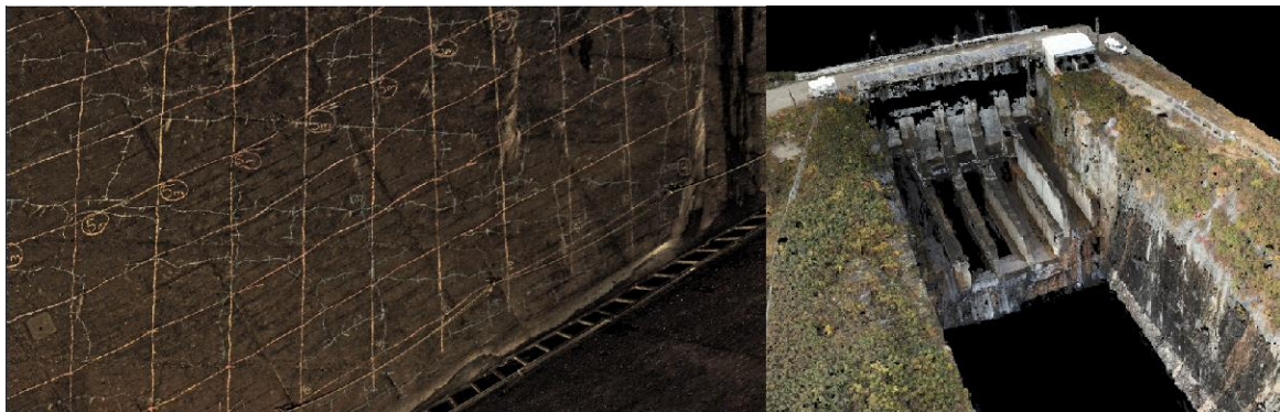
Figure 3 – Lasergrammétrie dans un passage hydraulique et photogrammétrie par drone sur un évacuateur
