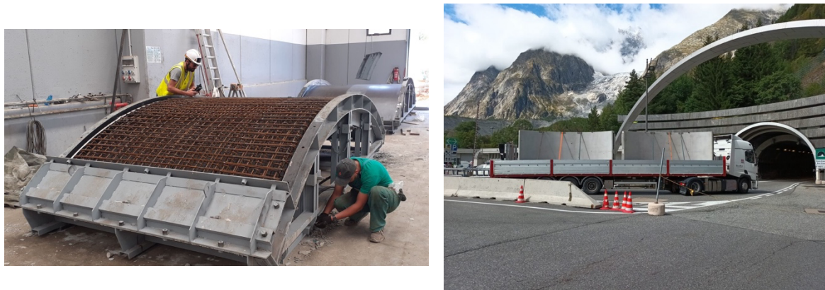
FIGURE 13. Parements préfabriqués : coffrage (à gauche) – transport (à droite)
