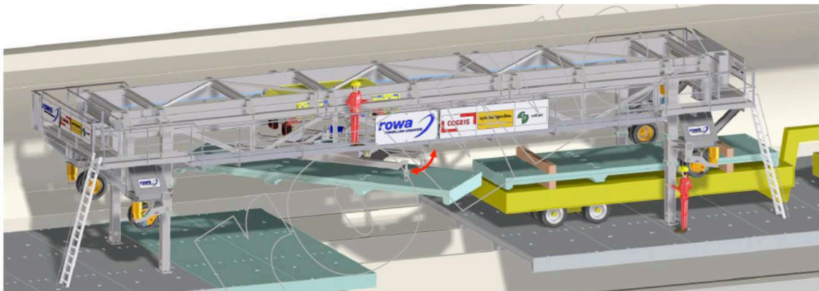
FIGURE 9. Pont de levage assurant la mise en place de 4 éléments préfabriqués de remplacement de la dalle détériorée en une nuit de travaux
