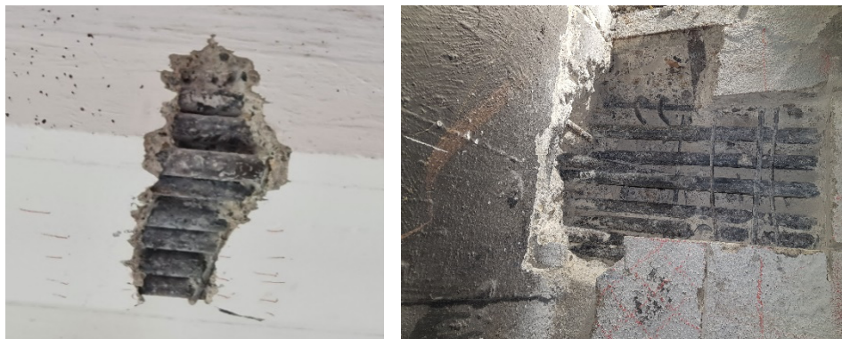
FIGURE 9. Sondages destructifs des armatures inférieures et supérieures des poutres
