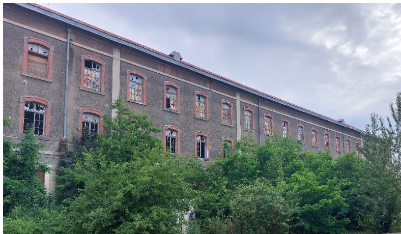
FIGURE 8. Bâtiment industriel à réhabiliter
