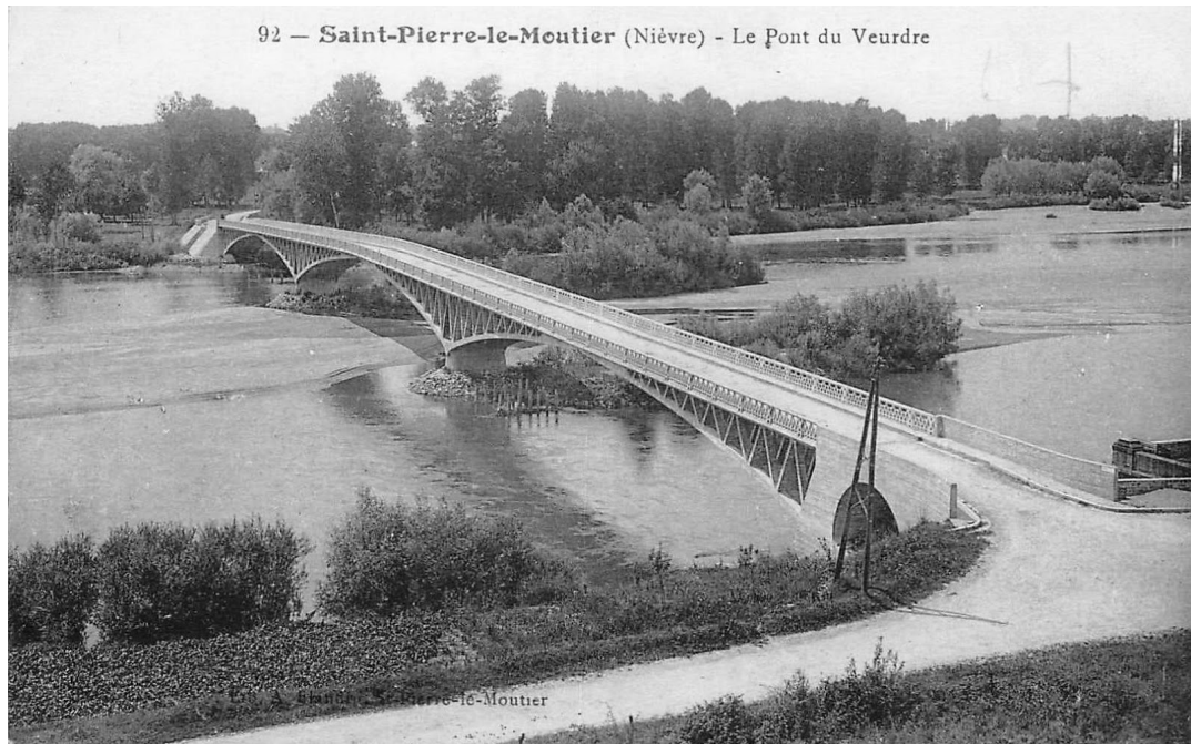
FIGURE 1. Vue du pont du Veurdre ( https://geodazner.blogspot.com/2016/05/pont-du-veurdre.html )
