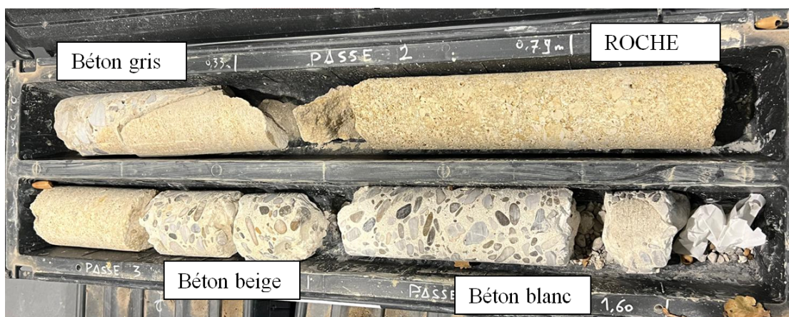
FIGURE 1. Photo du viaduc où les échantillons ont été prélevés et d'une carotte type prélevée sur le site
