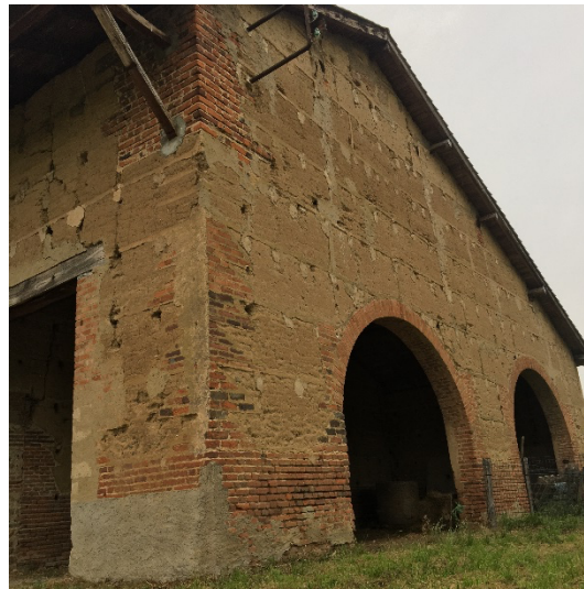
FIGURE 2. Grange en pisé à Saint-Trivier-sur-Moignans (01990).
