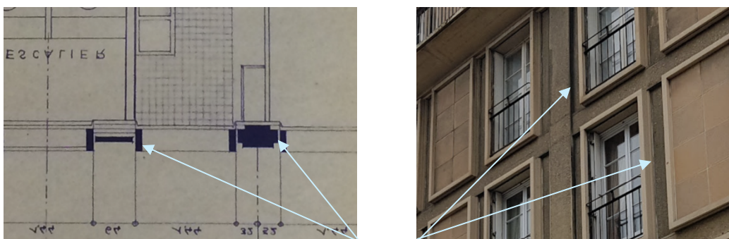
Risque de pathologies à long termes entre poteaux et remplissage
