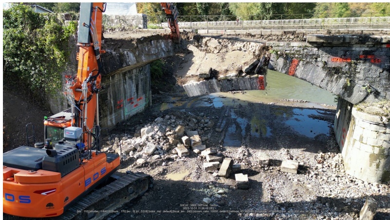
FIGURE 6: Déconstruction du pont
