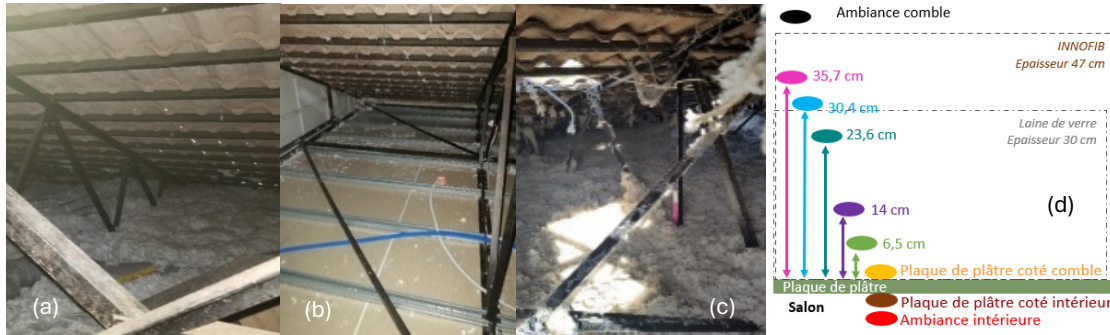
FIGURE 1. (a) phase avant, (b) sans l'isolant d'origine, (c) phase après, (d) positions des capteurs
