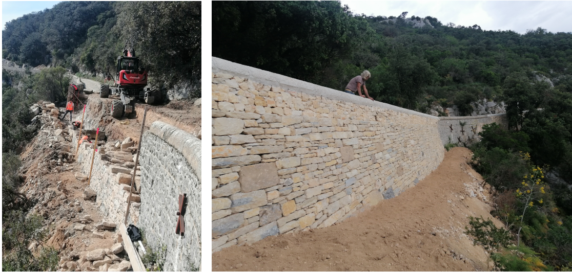
FIGURE 1. Murs de soutènement de la route de la Baume, Poulx (Gard)
