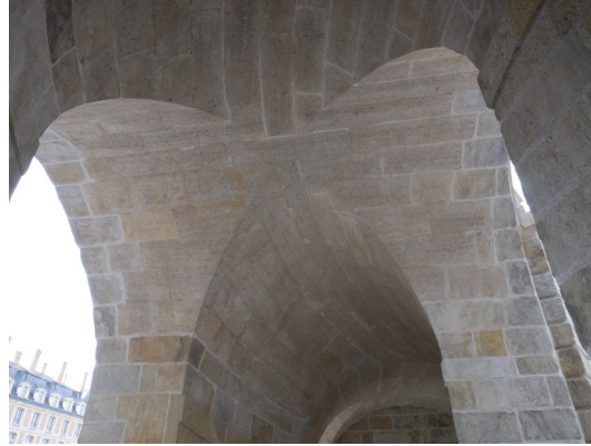
Figure 2. Voûtement étudié, au croisement d'un berceau hélicoïdal avec un arc rampant.
