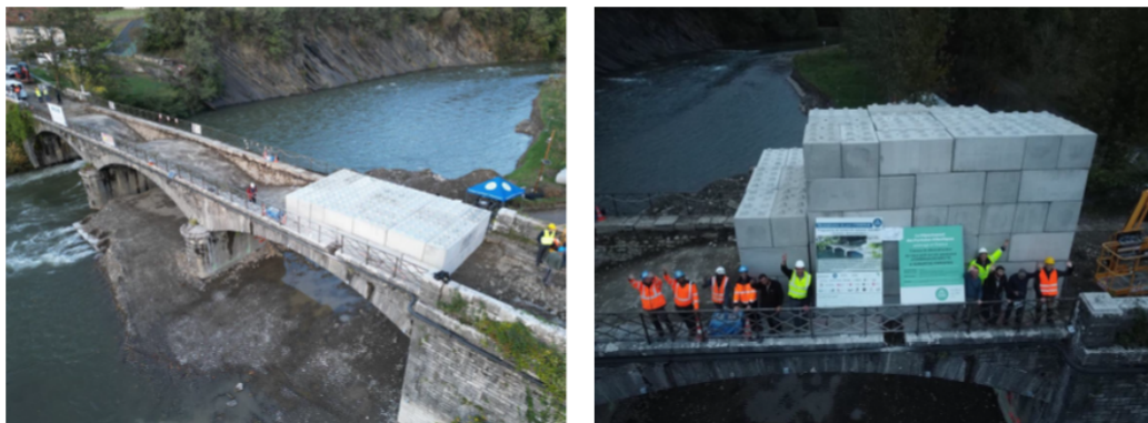
FIGURE 4. Mise en place du chargement sur le pont d'Osserain en octobre 2023 : Niveaux 1 et 2 (à gauche) et chargement final (à droite) (© G. Viossanges)
