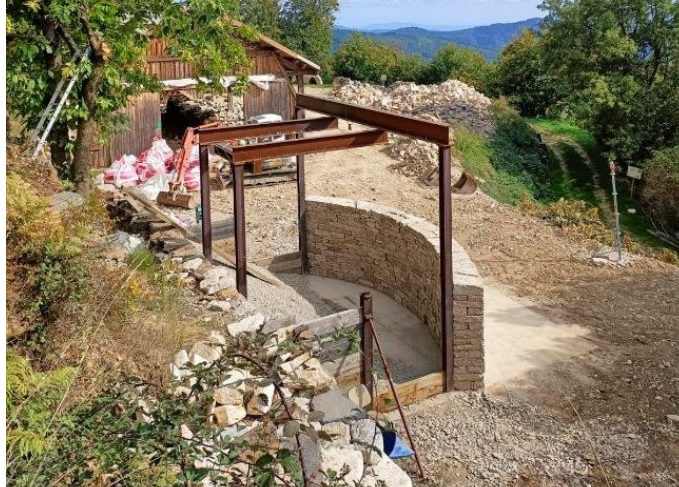
FIGURE 2. Le mur courbe expérimental en pierre sèche du programme LAUBAPRO
