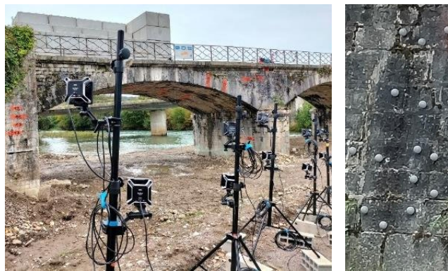
FIGURE 1. Installation du système de motion capture sur le pont d'Osserain : caméras infrarouges (à gauche) et cibles vissées sur le pont (à droite)
