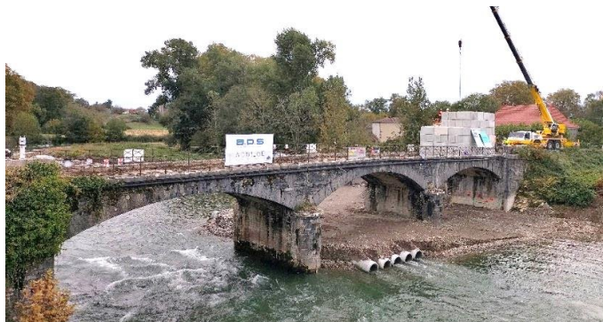
FIGURE 3. Le pont d'Osserain pendant son chargement
