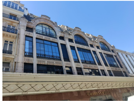
FIGURE 2. Façade Néo-byzantine avant les travaux (Sherlock Patrimoine – 2019)
