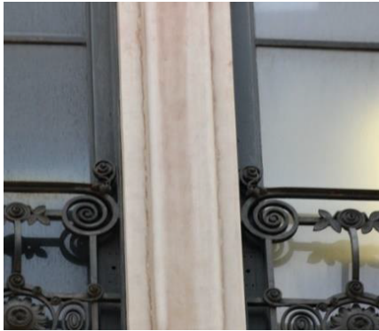
FIGURE 8. Pierre unie moulurée sur un poteau secondaire (Sherlock Patrimoine)
