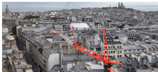
FIGURE 21. Déploiement de la grue (Studio Sherlock)
