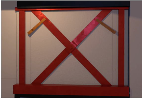
FIGURE 15. Vue de la structure métallique des arches après dépose des pierres (Studio Sherlock)
