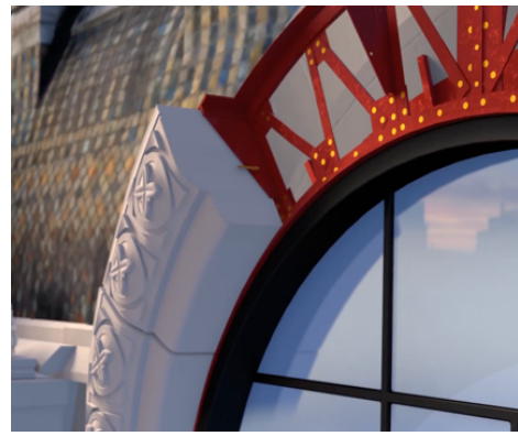
FIGURE 16. Vue de la structure métallique des arches après dépose des pierres (Studio Sherlock)
