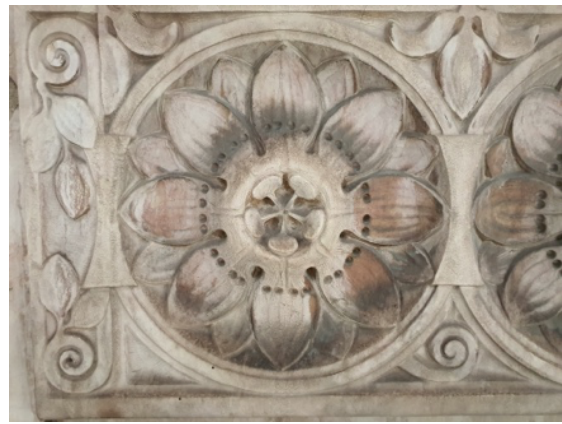
FIGURE 4. Détail d'ornement de la façade Néo-byzantine (Sherlock Patrimoine)
