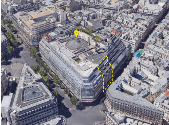
FIGURE 1. Localisation de la façade (entourée de pointillés jaunes) – Vue Google earth
