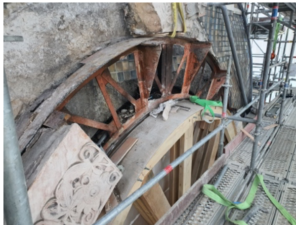
FIGURE 14. Vue de la structure métallique des arches après dépose des pierres (Sherlock Patrimoine)
