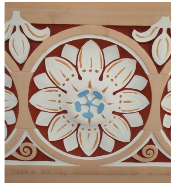
FIGURE 23. Détail de la façade après remise en peinture (Sherlock Patrimoine)
