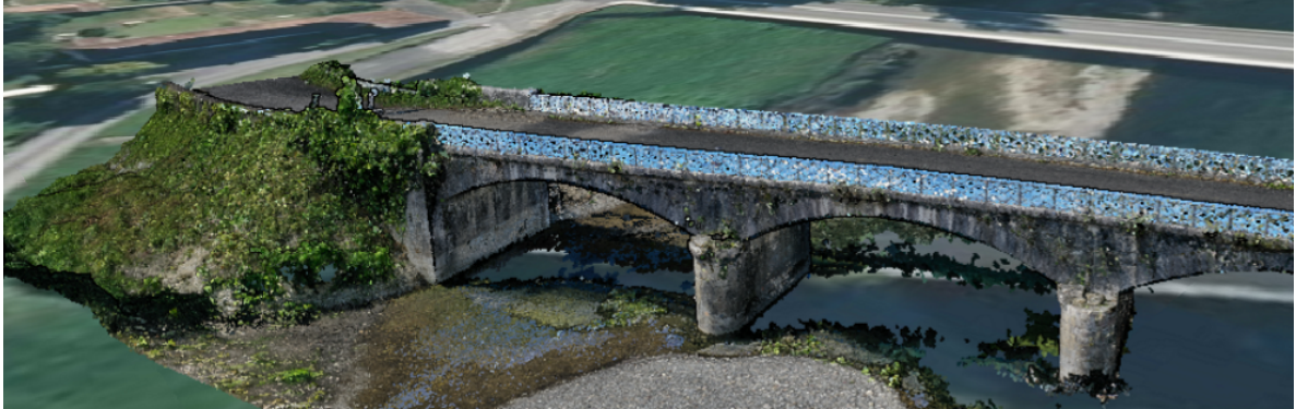
FIGURE 4. Nuage de points du pont d'Osserain réalisé par Géolithe (© Géolithe)
