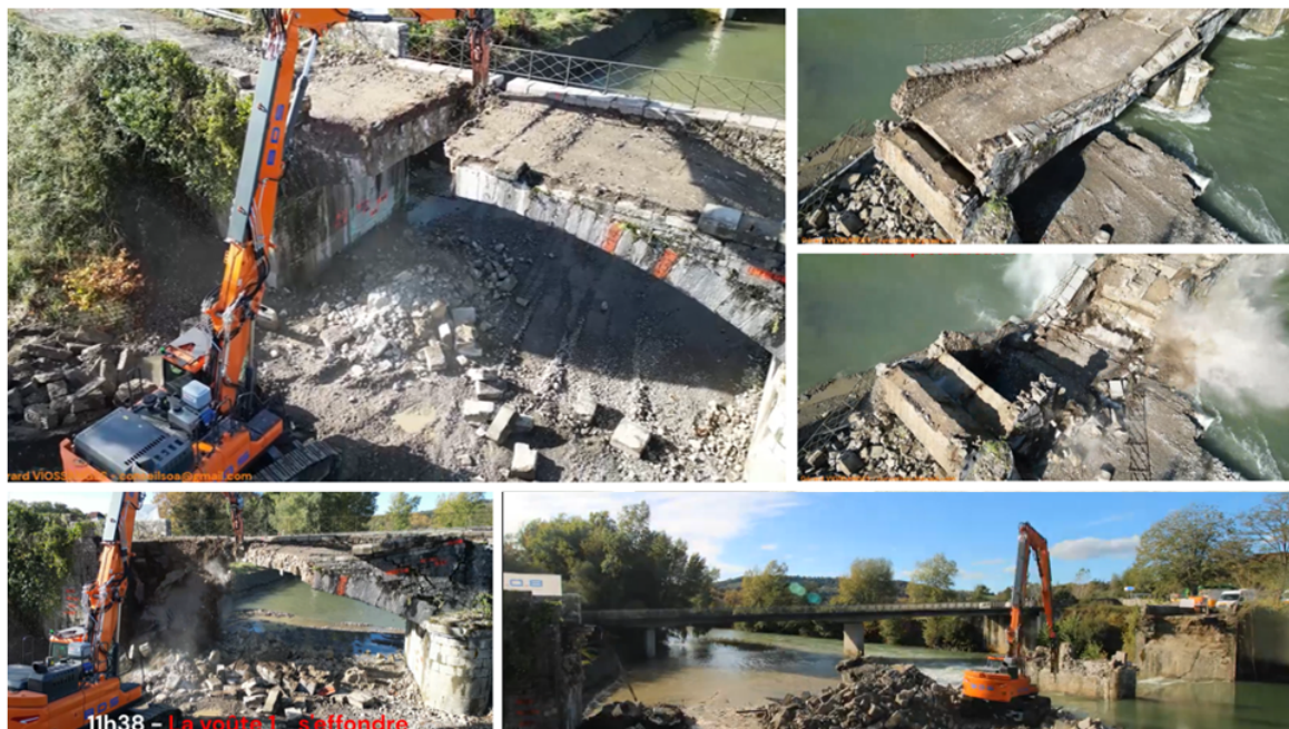
FIGURE 3. Images des dernières étapes de démolition, début novembre 2023 (© G. Viossanges)
