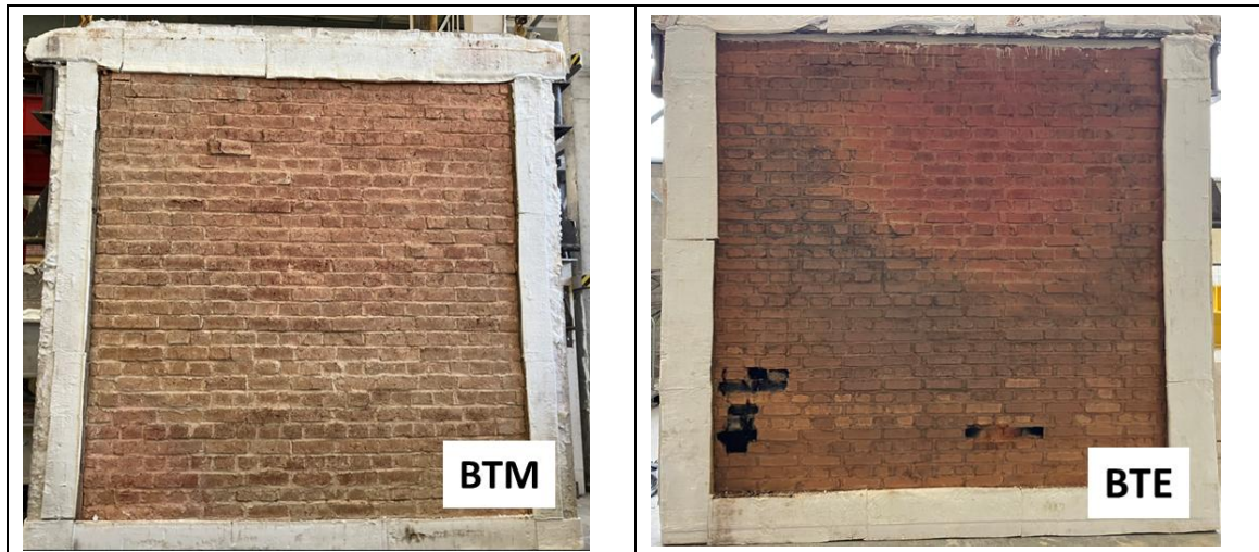
FIGURE 10. Photographies des faces exposées au feu des murs en briques BTM (à gauche) et BTE (à droite), après deux heures d'exposition à la courbe de température normalisée ISO 834-1, suivies de la phase de refroidissement et du chargement mécanique jusqu'à rupture.
