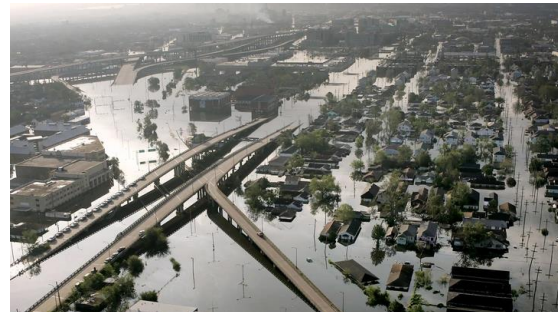
FIGURE 2. Inondation d'infrastructures routières, Nouvelle-Orléans, Ouragan Katrina, 2005 (David J. Phillip / AP)
