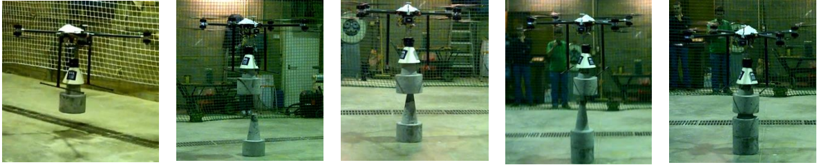
Figure 5. Réalisation d'une colonne en béton avec un drone.
