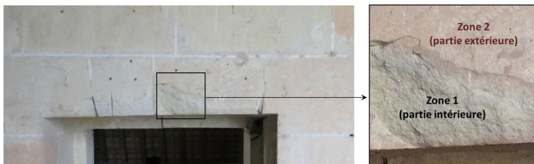
Figure 3. Zones soumises aux mesures colorimétriques, sur des pierres en tuffeau dans les combles incendiés du château de Chambord.
