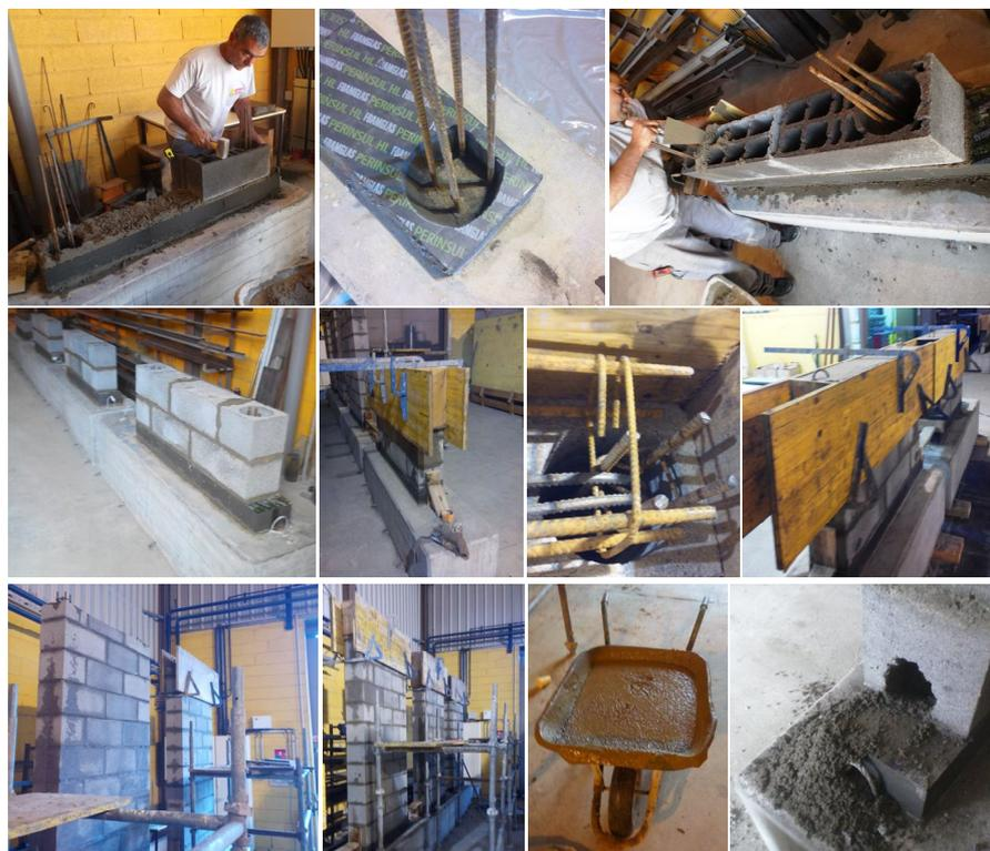
**Figure 4.** Réalisation des maquettes murs hauts et bas, mise en place du PERINSUL®, réalisation des chaînages avec un béton fluide et contrôle du remplissage des chaînages verticaux à la base.
