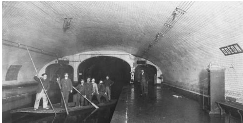
Figure 2. Station odéon inondée par remontée de la nappe en 1910 [BOI 48].
