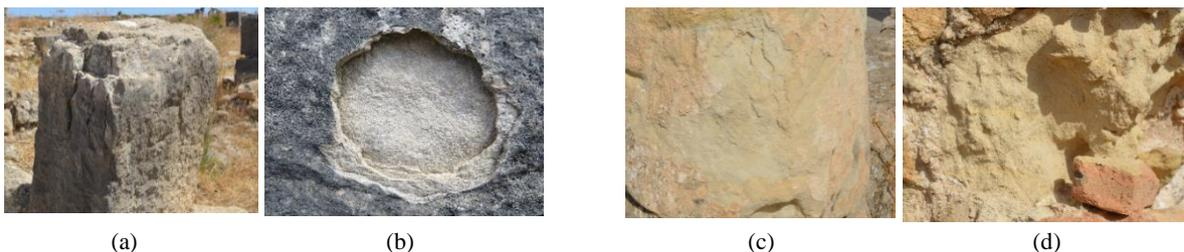
Figure 4 : Exemples d'altération du calcaire gris (Fissuration du calcaire gris (a) et desquamation en plaque (b)) et de la calcarénite (desquamation en feuillet (c) et désagrégration sableuse (d))
