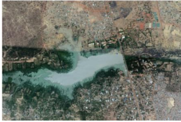
Figure 4 : Vue de la digue et de son réservoir, google earth 2017
