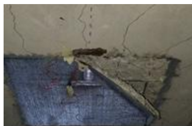
Figure 6. A) Décollement de Tissue en Fibre de Carbonne. B) Décollement du composite des dalles pré-chargées
