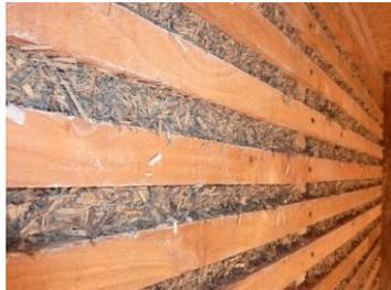
Figure 6: Coffrage perdu (150 - 200 kg/m<sup>3</sup>)
