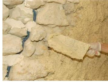
Figure 3: Correcteur thermique (800 – 900 kg/m<sup>3</sup>)
