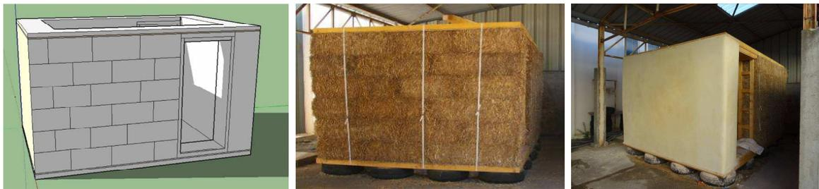
Figure 4. Module de 12 m<sup>2</sup> réalisé en paille porteuse – Enduit extérieur
