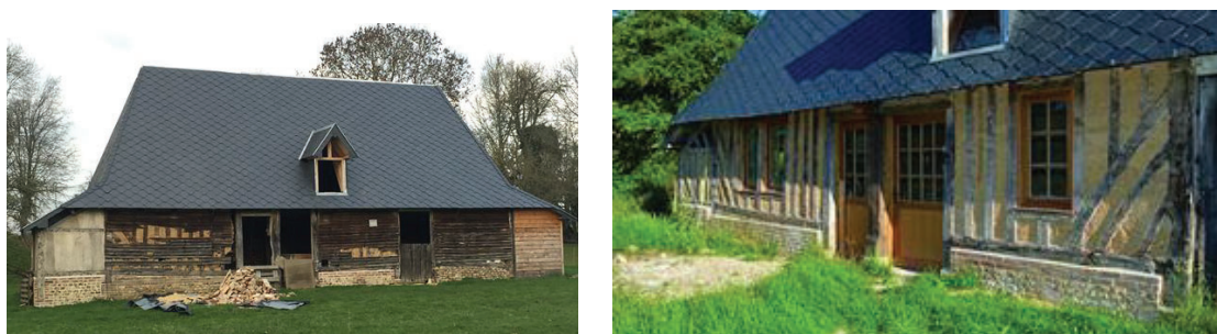
Figure 1. Ouvrage avant rénovation et après rénovation.
