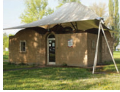
Figure 4. Face Est Maison en Terre du Campus (2016).
