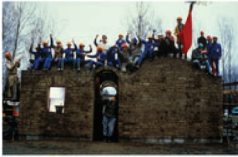
Figure 3. Fin de construction Maison 24h sur le Campus (décembre 1986)
